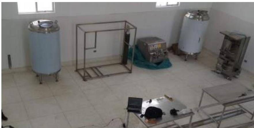
**Figura 64: Colocación de la estructura del pasteurizador, tanques de almacenamiento, homogenizador y llenadora**
