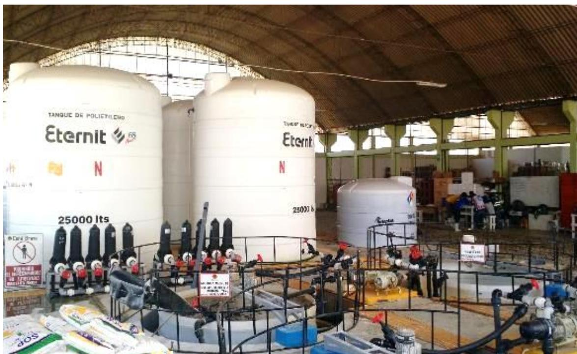
**Figura 20:** Foto Sistema de almacenamiento y distribución de fertilizantes líquidos.
