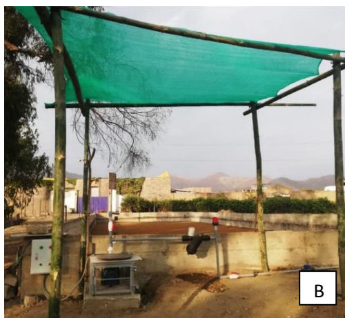
Figura 49: A: Cabezal de riego. B: Colocación de la malla Raschel en el cabezal de riego
