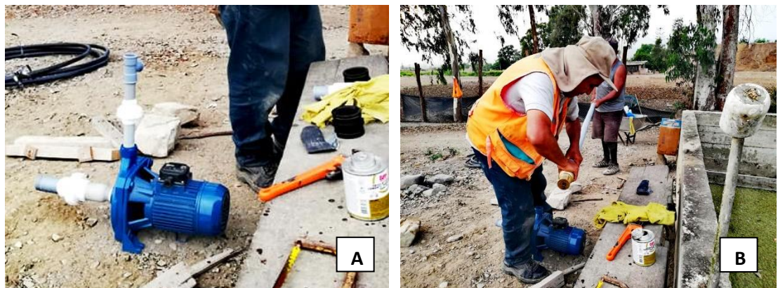
Figura 45: A: Instalación de accesorios en la electrobomba. B: Tubería de succión
