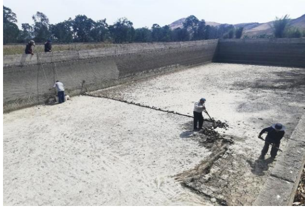
Figura 30: Trabajos de limpieza en el reservorio
