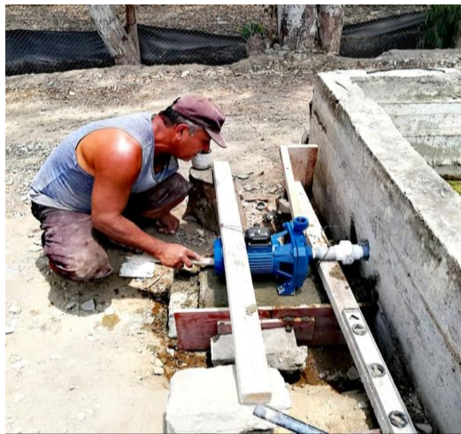
Figura 44: Construcción de la plataforma de anclaje de la electrobomba
