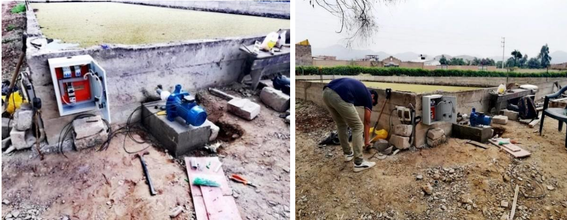
Figura 46: Instalación del tablero eléctrico y electrobomba
