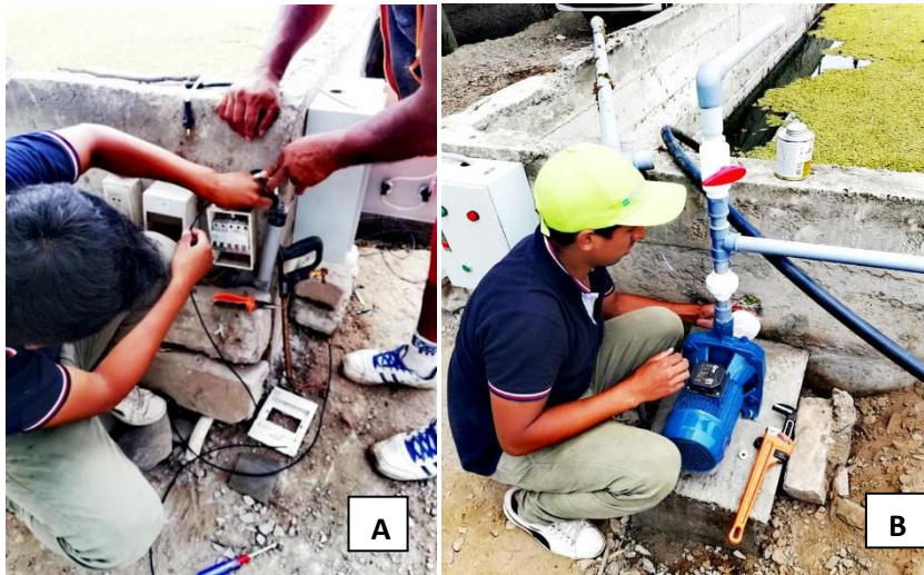
Figura 47: A: Tablero eléctrico. B: Presentación de la electrobomba e instalación de tubería de succión
