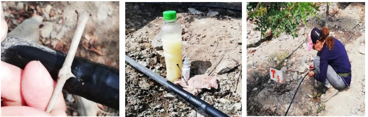
Figura 64: Secuencia de la limpieza de los laterales de riego
