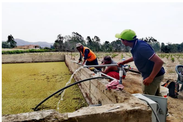
Figura 48: Prueba de funcionamiento del cabezal de riego
