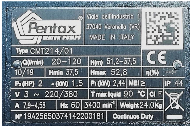
Figura 36: Electrobomba Pentax modelo CMT214 FUENTE: Extraído de Pentax serie CM (2020).
