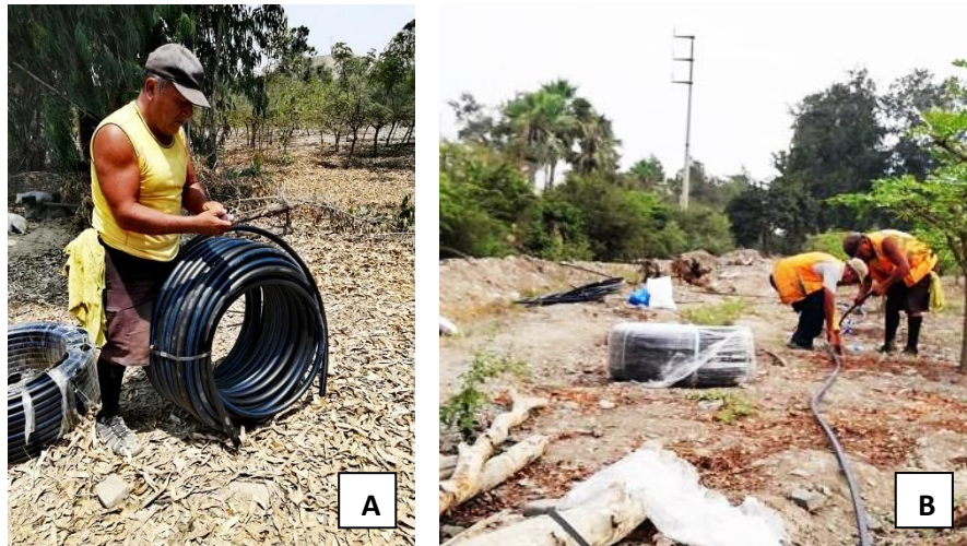
Figura 39: A: Desenrollado de la tubería de conducción. B: Tendido de la tubería de conducción
