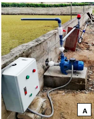
Figura 49: A: Cabezal de riego. B: Colocación de la malla Raschel en el cabezal de riego
