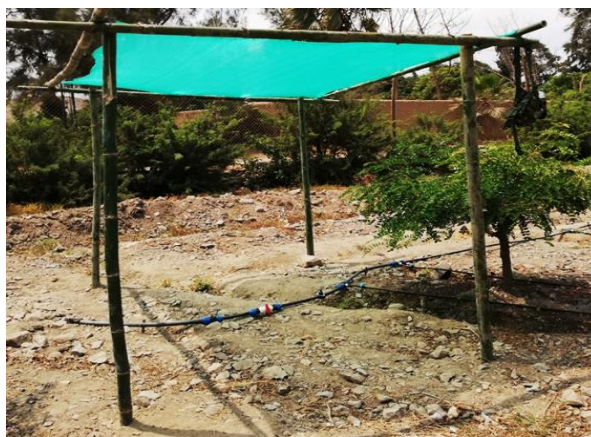
Figura 50: Colocación de la malla Raschel al inicio del portalateral
