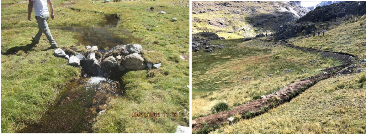
Figura 19: Construcción de diques (izquierda), canales de distribución (derecha)
