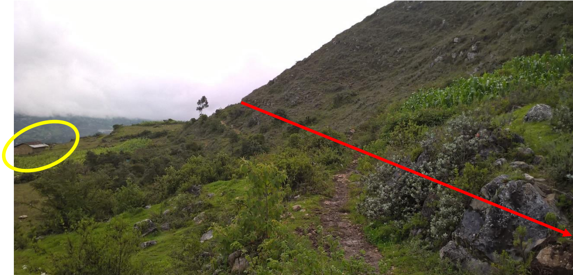
Figura 15: Trazo del canal y casas cercanas en su recorrido vista atras
