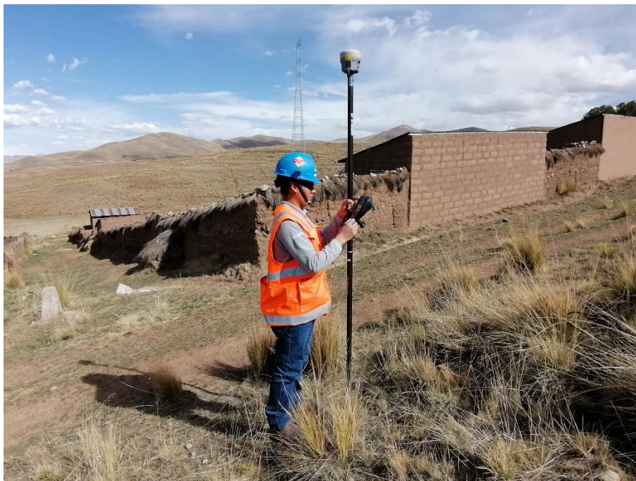
Figura 31: Replanteo topográfico centro comunal Marquiri Tintaya.
