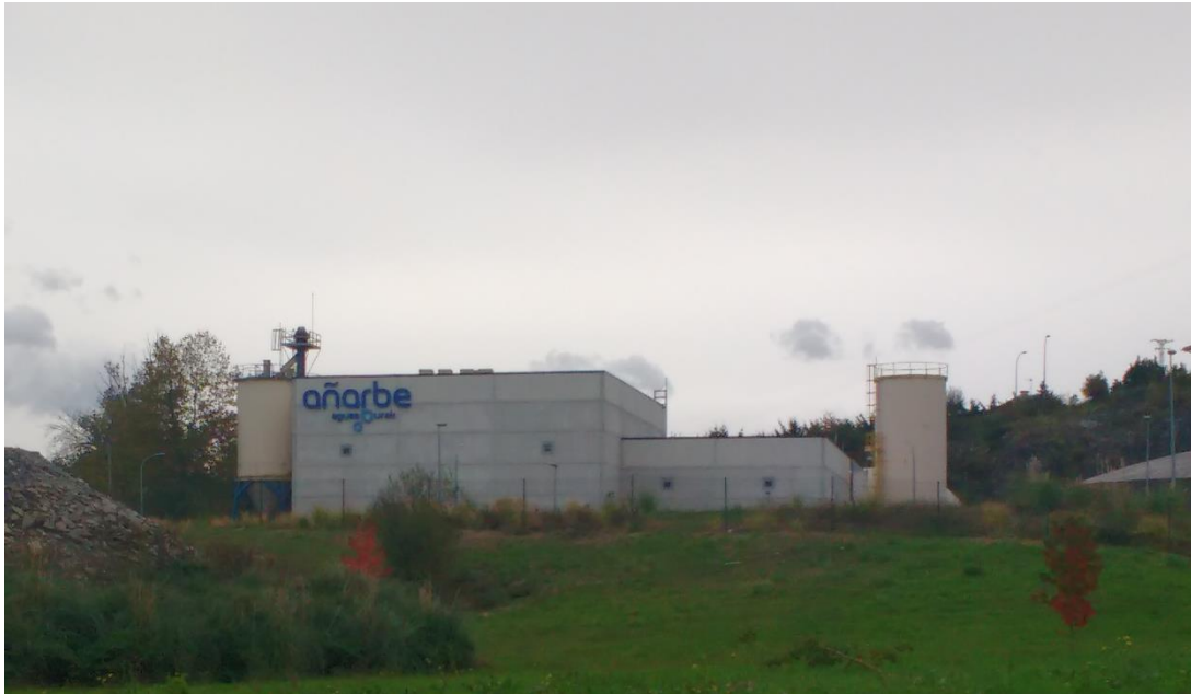
Figura 20: Planta de tratamiento de Aguas residuales (PTAR) Loiola de San Sebastián, perteneciente al consorcio de Aguas de Añarbe S.A.
