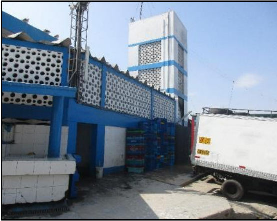
Foto 20. Tanque elevado de agua para agua potable y salada
