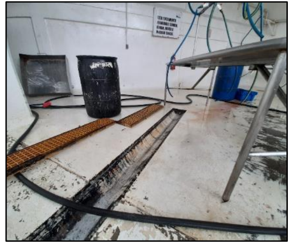
Foto 25. Canaletas en sala de Tareas Previas con sección en "U"
