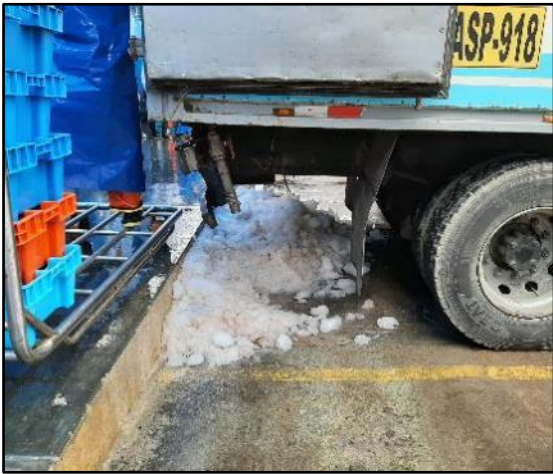
Foto 7. Tramo de área de despacho sin canaleta
