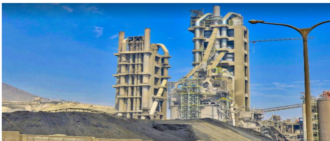
Figura 27: Empresa cementera en el distrito de Villa María del triunfo, provincia de Lima a 187 m.s.n.m.
