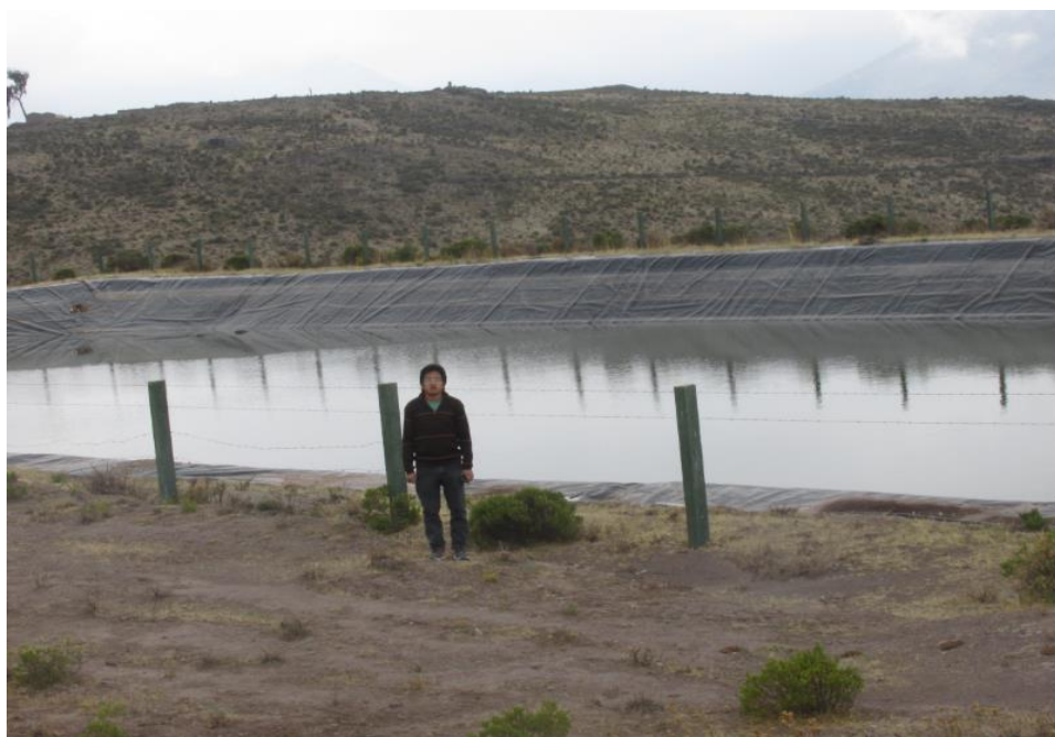
Figura 38: Reservorio en el distrito de San Andrés de Tupicocha, provincia de Huarochiri a 3891 m.s.n.m
