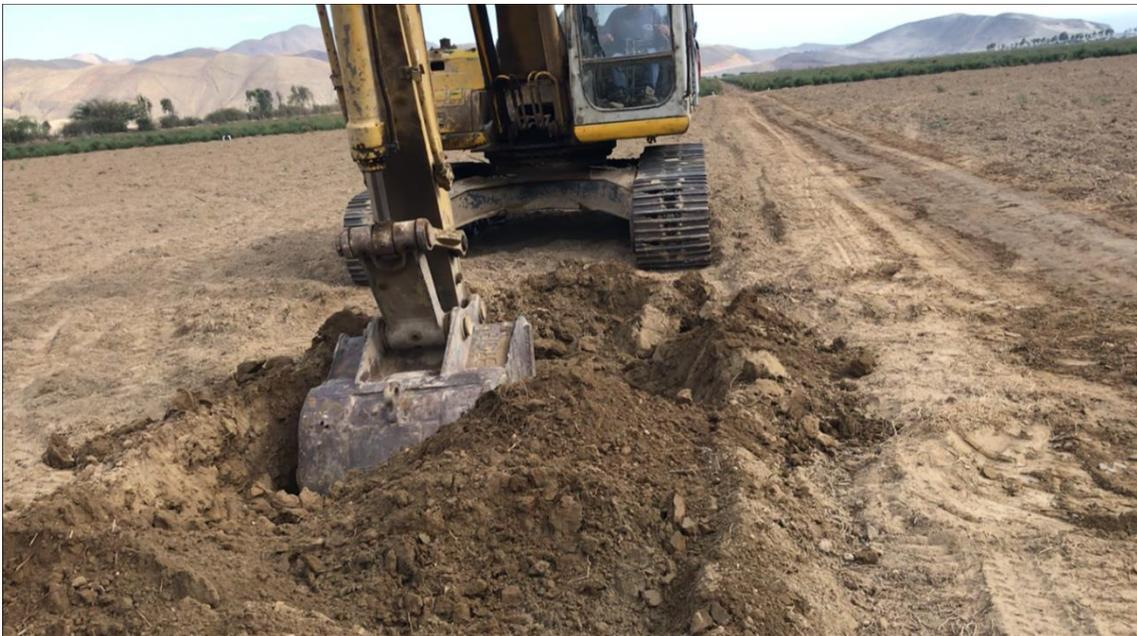
**Figura N°03 Primer mezclado suelo con excavadora**
