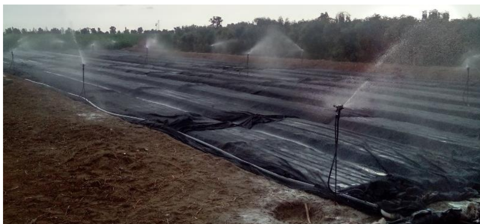
Foto 6: Instalación de sistema de riego por aspersión.
