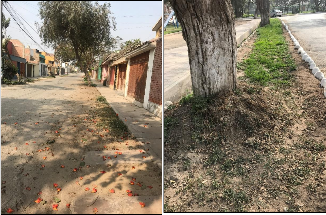
Figura 12. Bermas sin mantenimiento en el Distrito. Fuente: Elaboración Propia.
