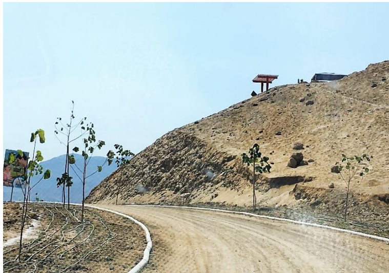
Figura 17: Vista de Perfil izquierdo del Talud
