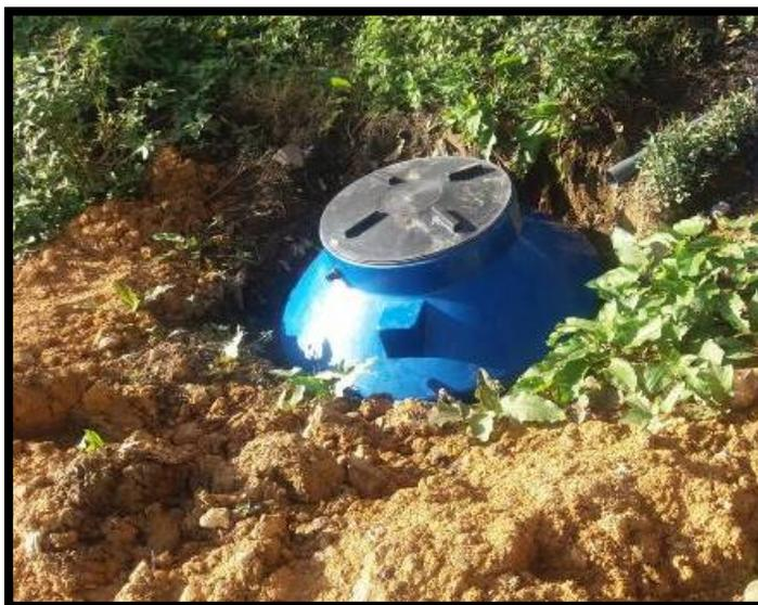
Figura N° 06: Implementación de tanques para la elaboración de biol con residuos del agua del beneficio húmedo.
