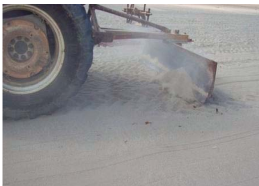
Figura 12. Nivelación del terreno con la pala trasera niveladora
