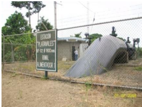
Foto 4. Alimentador 1 en tuberías de plástico
