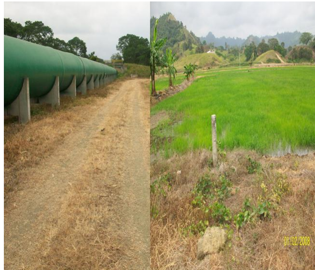
Foto 1. Vista de la tubería principal en tubería de plástico reforzado
