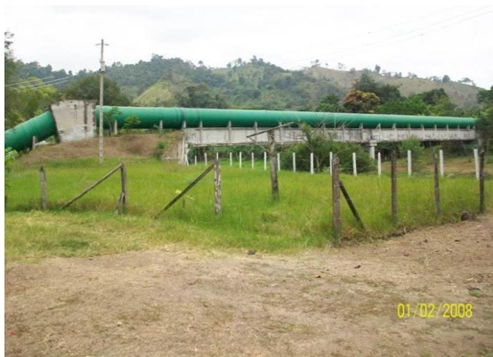
Foto 2. Paso de tubería por medio del puente
