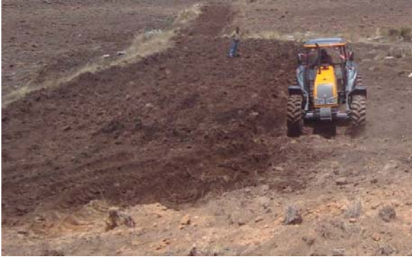
Foto 1. Preparación de terreno
