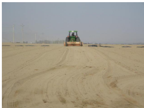
Foto 5: Nivelación del terreno
