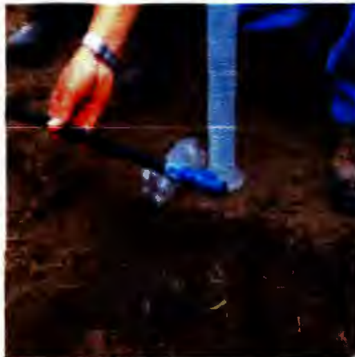
Figura 41: Limpieza de laterales de riego Fuente: Manual de Supervisión de sistemas de riego tecnificado PSI (2007)
