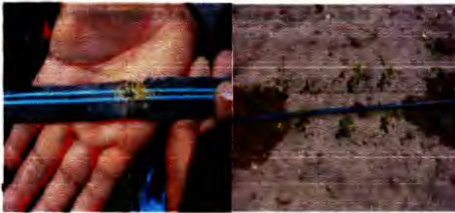
Figura 40: Goteros obstruidos por arcilla en suspensión Fuente: Manual de Mantenimiento de equipos de riego-Pilar Gil (2010)
